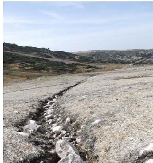
Foto 42: Vista para as linhas de drenagem natural, faltando a colocação de terras para a regeneração da vegetação autóctone
