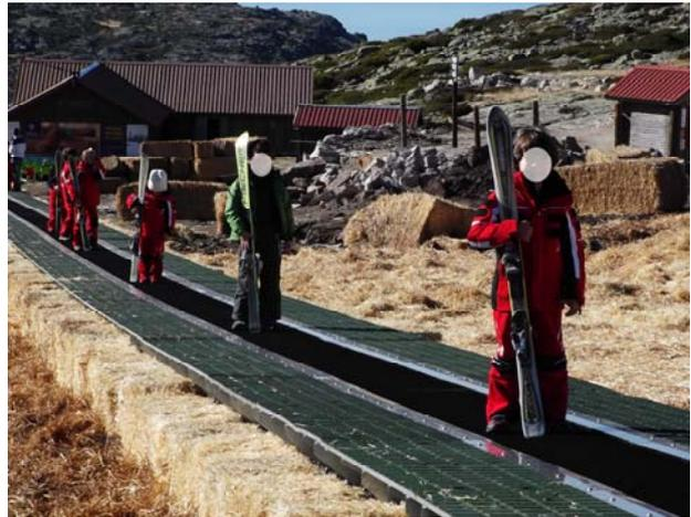
Foto 39: Vista da estrutura do tapete rolante escola sobrelevado relativamente ao nível do solo envolvente (antes e depois do espaço que medeia entre o solo envolvente e o topo do tapete rolante ser colmatado com fardos de palha).
