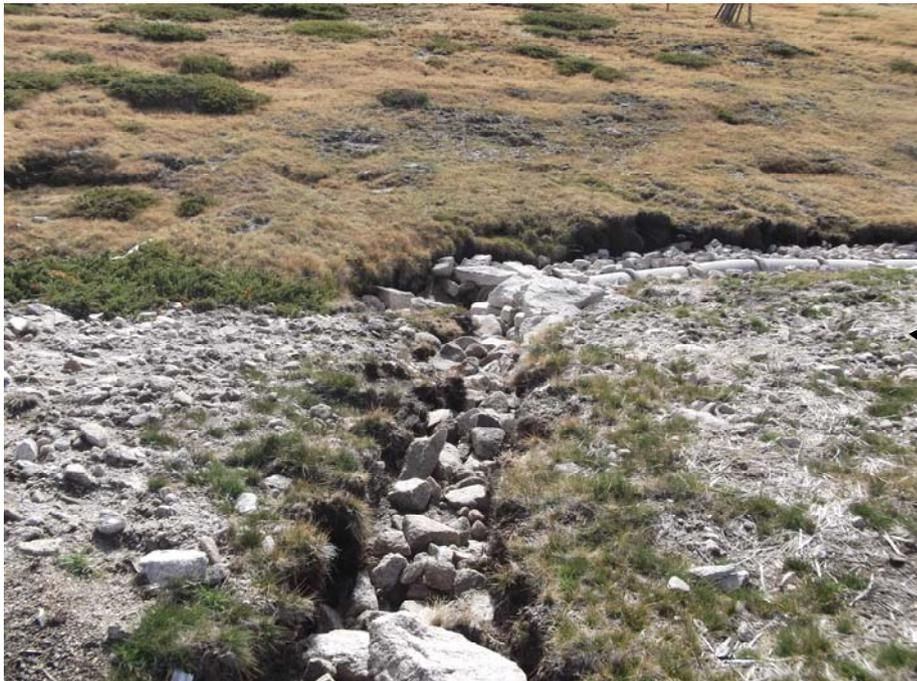
Foto 30: Junção da linha de escorrência proveniente da estrada N339 (com enrocamento colocado à mão) com a linha de drenagem com manilhas de betão.
